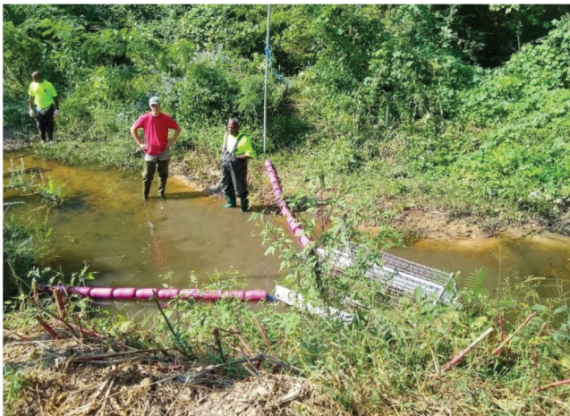
Lắp đặt Litter Gitter, hay bẫy rác, được lắp đặt dọc theo một con lạch ở Hoa Kỳ.
